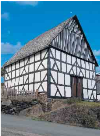
Fachwerkfassade und die Fachwerkbalken
