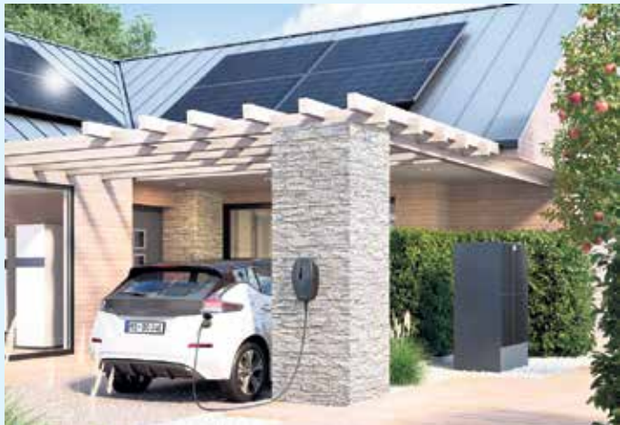
Modernes Einfamilienhaus mit PV, Wärmepumpe und Wallbox
