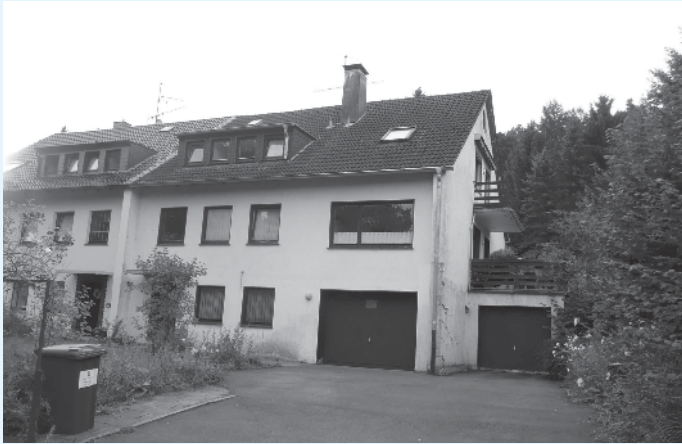
Haus vor dem Anbau
