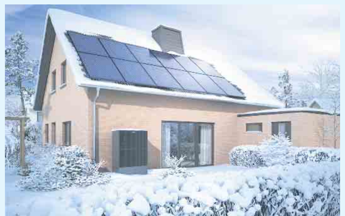
Modernes Wohnhaus mit Wärmepumpe, kombiniert mit Photovoltaik
