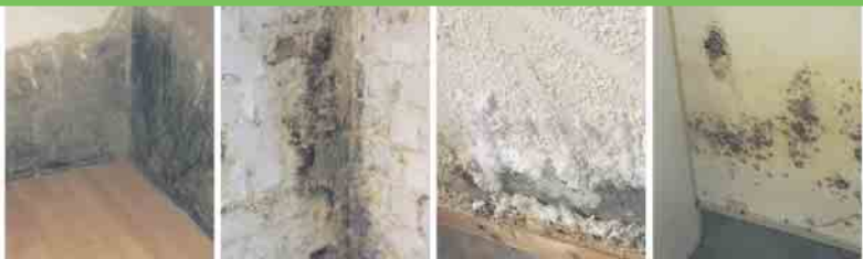
Defekte Horizontalsperre Querdurchfeuchtung Ausblühungen Schimmelbefall
