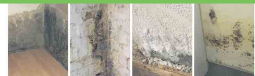
Defekte Horizontalsperre
