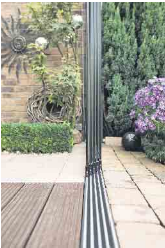
Ganzglas-Schiebeanlagen zeichnen sich durch eine besonders schlanke Konstruktion aus. Sie werden auf Laufschienen geführt. Foto: DJD/ Bundesverband Wintergarten e.V.
