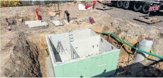
6,50 mal 6,50 Meter Baugrube reichen für einen kompakten Teilkeller meist schon aus. Foto: GÜF/Glatthaar Keller
