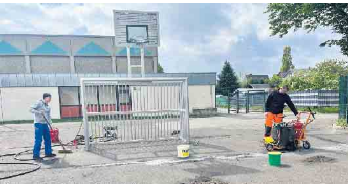
Auf dem Kleinspielfeld waren die Mitarbeiter des Bauhofs aktiv: Sie reinigten die Fugen, verfüllten mit Asphalt versiegelten die Fläche mit einer Bitumenschicht.
