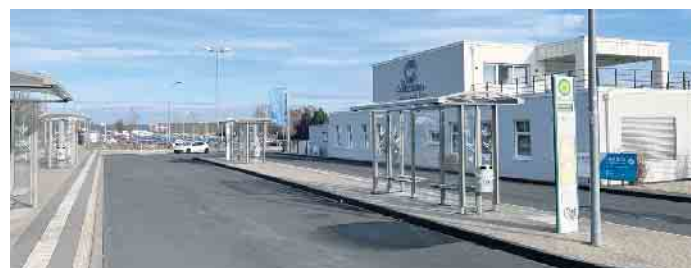
Instandsetzung der Wartehäuschen
