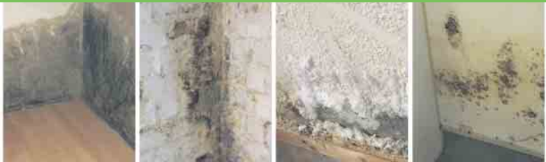
Defekte Horizontalsperre Querdurchfeuchtung Ausblühungen Schimmelbefall
