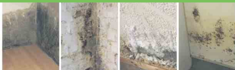
Defekte Horizontalsperre Querdurchfeuchtung Ausblühungen Schimmelbefall
