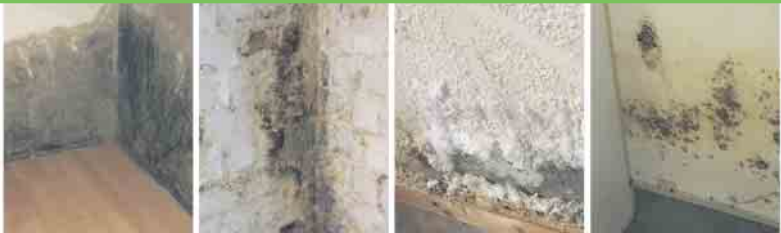
Defekte Horizontalsperre Querdurchfeuchtung Ausblühungen Schimmelbefall
