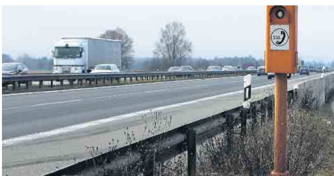
Alle zwei Kilometer steht eine Notrufsäule an der Autobahn. Ein Pfeil und eine Zahl auf den Leitpfosten geben Richtung und Abstand an. Foto: Antranas/pixabay.com/mid/ak
