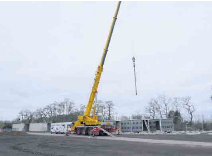
Der Lastkran bei den Aufstellarbeiten der Containeranlage für die Ersatzschule
