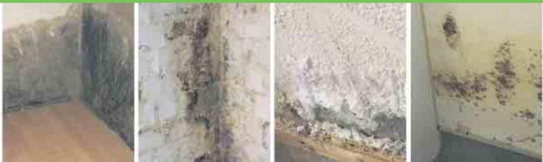
Defekte Horizontalsperre Querdurchfeuchtung Ausblühungen Schimmelbefall
