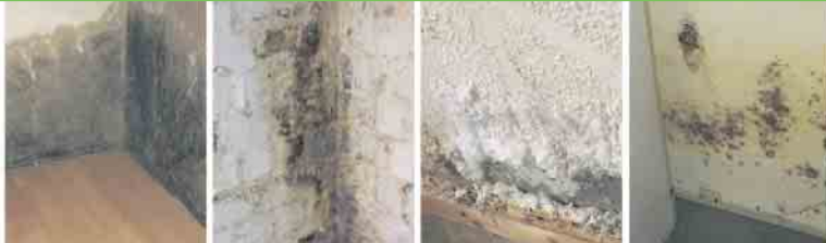
Defekte Horizontalsperre
