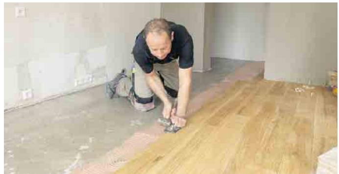
Ein Profi klebt die Eichendielen vollflächig auf den Untergrund. Dass sichert eine gute Wärmeübertragung durch die Fußbodenheizung und sorgt für einen niedrigen Trittschall. Der eingesetzte Klebstoff trägt das Emicode-Zeichen EC 1. Dieses Siegel gewährleistet geringste Emissionen und schont die Gesundheit der Verarbeiter und Bewohner. Foto: Initiative Parkett im Klebeverbund (PIK)
