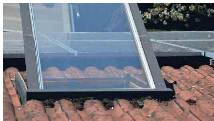
Anschlüsse an Dachdurchdringungen bei Dachfenstern werden beim DachCheck begutachtet. Foto: HF Redaktion/akz-o
