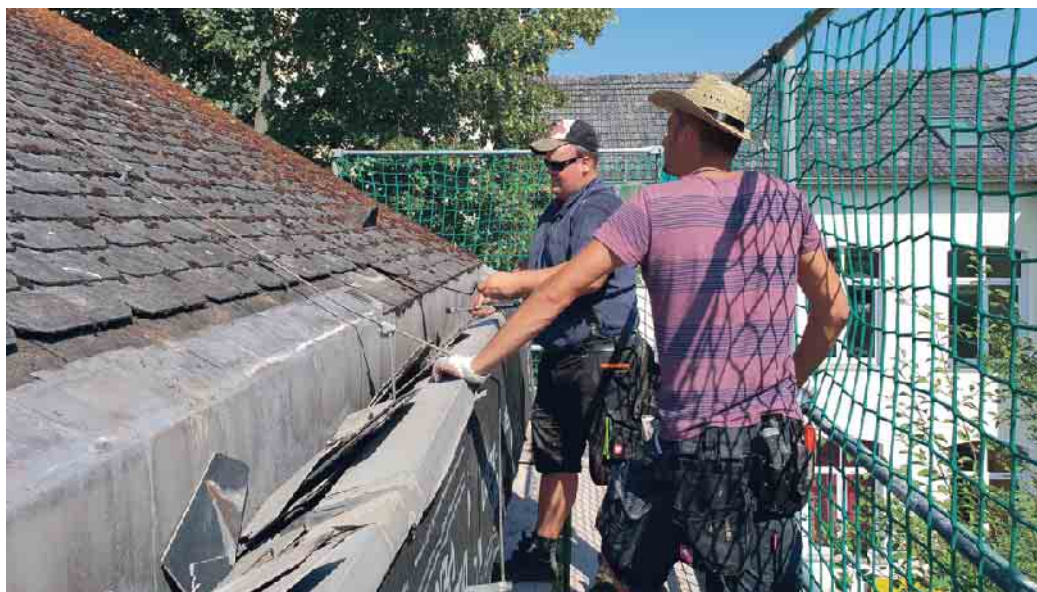
Verklammerung und Befestigung der Dachziegel bzw. -platten werden beim DachCheck geprüft. Foto: ZVDH/akz-o
