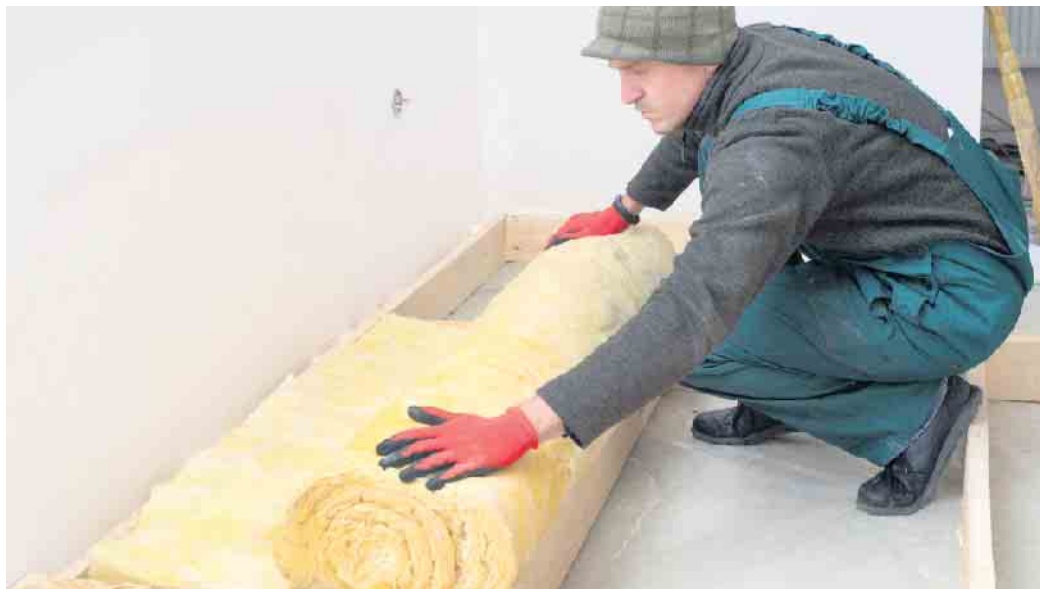
Eine Dämmung aus Mineralwolle senkt den Energieverbrauch und die damit verbundenen Kosten eines Gebäudes bei gleichzeitig verbessertem Schall- und Brandschutz. Einfache Maßnahmen können in Eigenregie durchgeführt werden. Foto: djd/www.der-daemmstoff.de/Smole - stock.adobe.com
