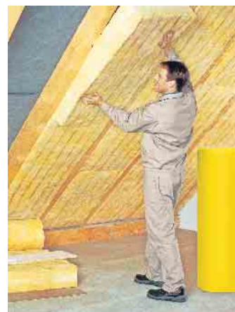
Die meiste Energie bei Ein- und Zweifamilienhäusern geht über das Dach verloren. Eine Dämmung mit Mineralwolle etwa kann je nach baulichem und energetischem Zustand den Heizwärmebedarf um bis zu 35 Prozent senken. Foto: djd/www.der-daemmstoff.de
