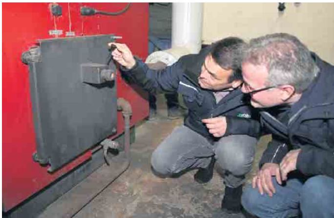
Wiehls Klimaschutzmanager Torsten Richling und Hausmeister Peter Schenker inspizieren die Klappe, hinter der das Hackschnitzel-Feuer lodert.
