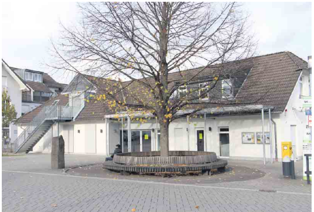
Neues Leben in einem traditionsreichen Gebäude: Der renovierte Henseler Hof in Niederbachem. Fotos: Stephan Zieger
