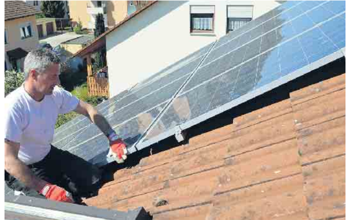
Der qualifizierte Dachdecker prüft die Befestigungen der Solarmodule und begutachtet die Unterkonstruktion im Rahmen des DachChecks. Foto: HF Redaktion/akz-o
