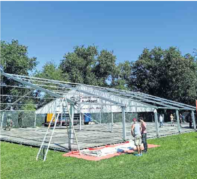
Das Gerüst für das Zelt steht.
