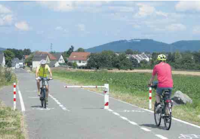
Schranke auf Berkumer Weg stoppt Autoverkehr. Foto: ADFC Wachtberg
