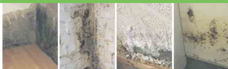
Defekte Horizontalsperre
