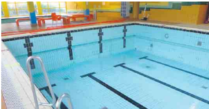
Bei der anstehenden Hallenbad-Sanierung werden u.a. die Fliesen in den Schwimmbecken erneuert. (Foto: Architekturbüro Haas)
