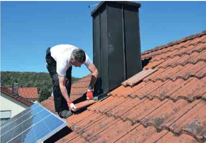
Anschlüsse an Dachdurchdringungen werden beim DachCheck begutachtet. Foto: HF Redaktion/akz—o
