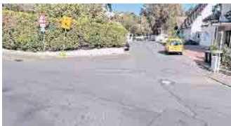
Am Langenacker: Bisher mussten die Kinder am „Forstweg“ die Straße queren, ein durchgehender Gehweg wird künftig mehr Sicherheit bringen. (Foto: Gemeinde Wachtberg/jd)
