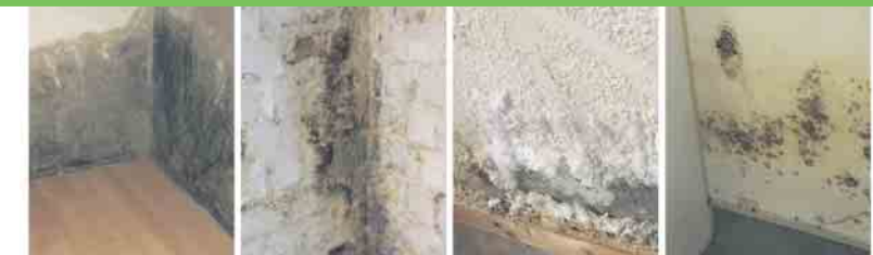
Defekte Horizontalsperre Querdurchfeuchtung Ausblühungen Schimmelbefall
