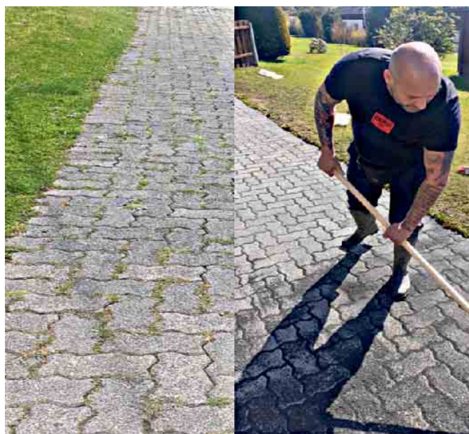
Reinigung von Fugen vorher und nachher.
