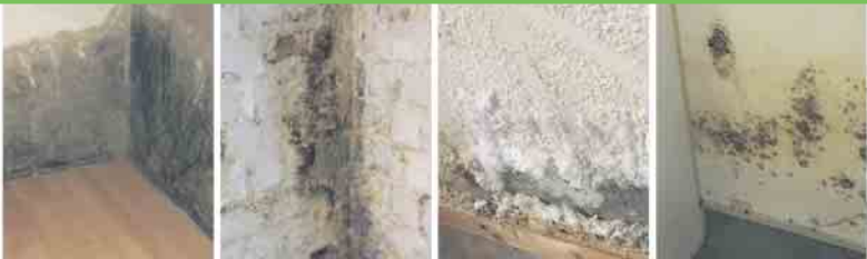
Defekte Horizontalsperre Querdurchfeuchtung Ausblühungen Schimmelbefall
