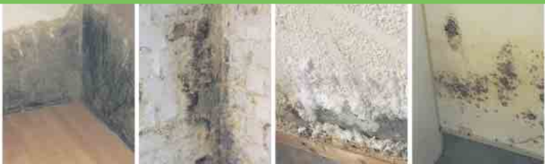
Defekte Horizontalsperre Querdurchfeuchtung Ausblühungen Schimmelbefall
