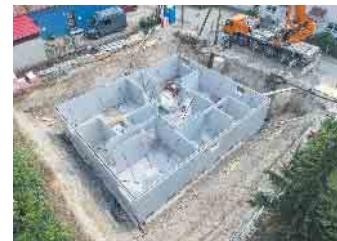
Ein Fertigkeller wird aus industriell vorgefertigten Bauteilen errichtet. Foto: GÜF/Knecht Kellerbau
