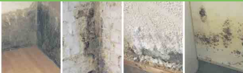
Defekte Horizontalsperre
