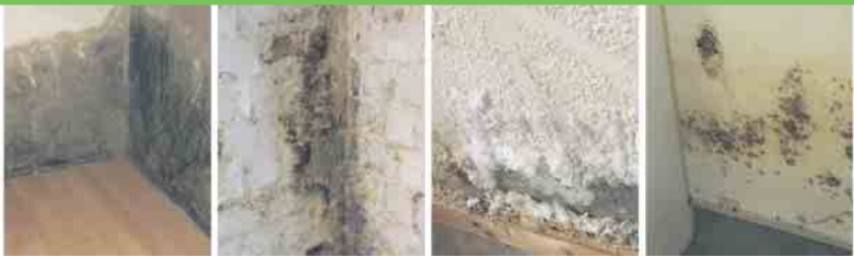
Defekte Horizontalsperre Querdurchfeuchtung Ausblühungen Schimmelbefall
