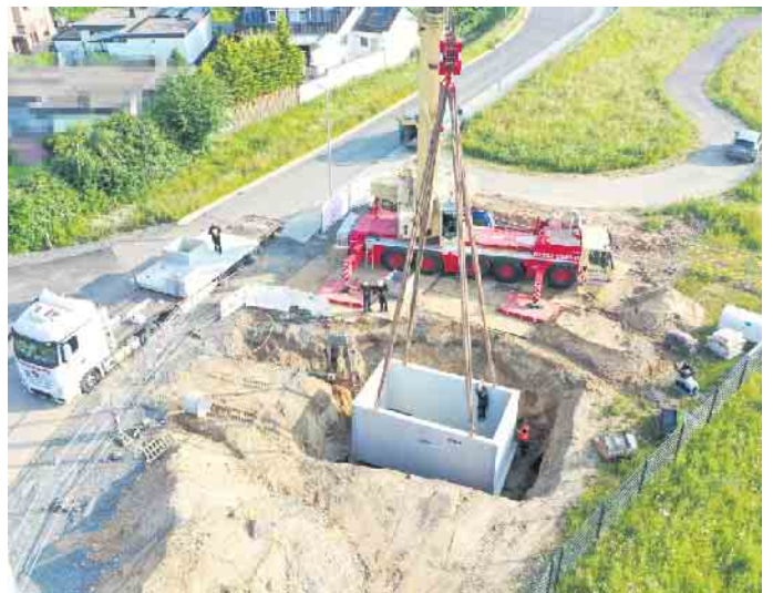
Stolze 2,4m Breite und 5,5m Höhe misst die 2,7m tiefe Brunnenstube, die nun im Neubaugebiet „Auf dem Grend“ in den Boden eingelassen wurde und künftig die CO 2 -freie Wärmeversorgung der Anwohner sichert. Foto: Sebastian Ehlen GmbH
