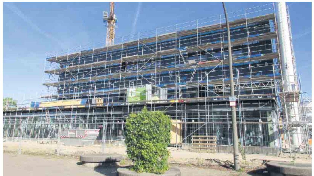
Die Bauarbeiten schreiten voran; Foto: Stadtbibliothek Troisdorf
