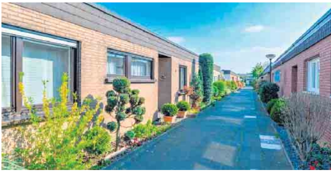
Auch schon 50 Jahre alt: Die Flachdach-Siedlung Gartenstadt
