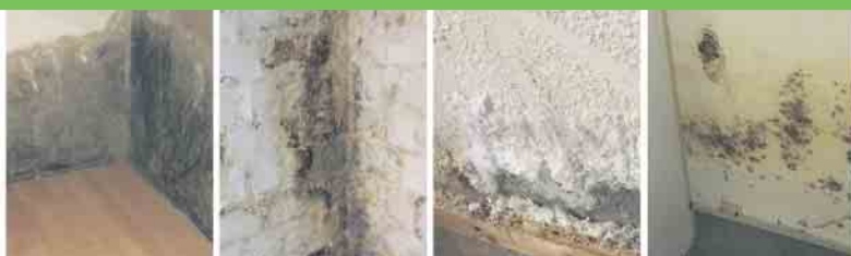
Defekte Horizontalsperre
