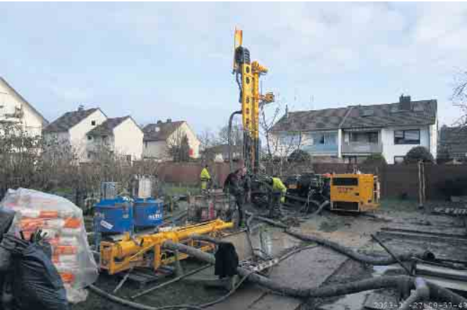
vier Bohrungen 90 Meter Tiefe, um die notwendige Wassermenge fördern zu können. Foto: Piel
