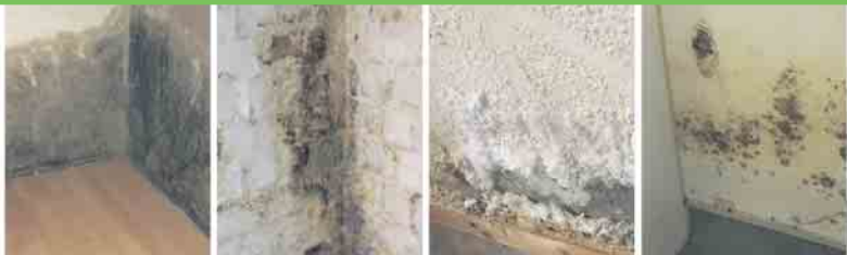
Defekte Horizontalsperre Querdurchfeuchtung Ausblühungen Schimmelbefall
