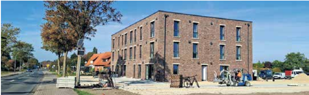
Zum Zeitpunkt dieser Aufnahme Anfang Oktober sind die Bauarbeiten noch in vollem Gange. Foto: Mareile Mattlage
