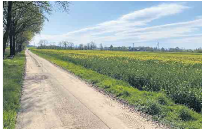
Fahrradtauglich und gut zu befahren: Der Weg Auf der Imlage wurde mit Schotter und Brechsand saniert
