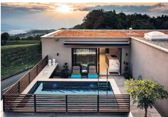
Pool-Platz auf der Terrasse. Foto: Rüegg Schwimmbäder/akz-o
