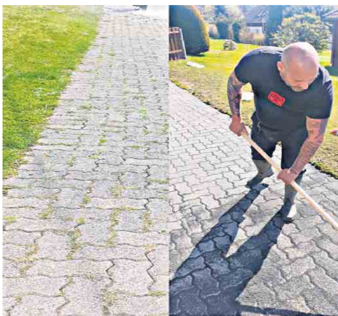
Reinigung von Fugen vorher und nachher.
