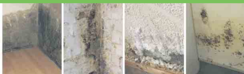
Defekte Horizontalsperre
