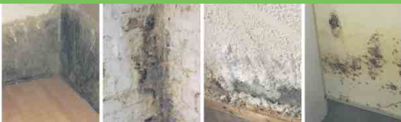
Defekte Horizontalsperre
