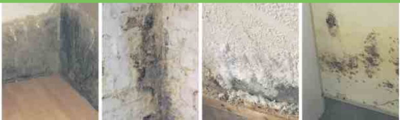
Defekte Horizontalsperre Querdurchfeuchtung Ausblühungen Schimmelbefall
