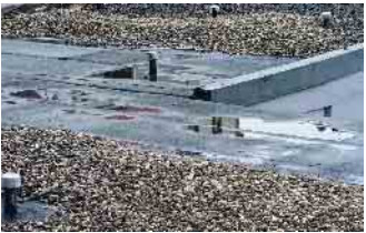
Ein Flachdach wie dieses mit stehendem Wasser und Rissen in den Dachbahnen sollte dringend saniert werden. Foto: Datenschutz-Stockfoto/shutterstock/Triflex/akz-o
